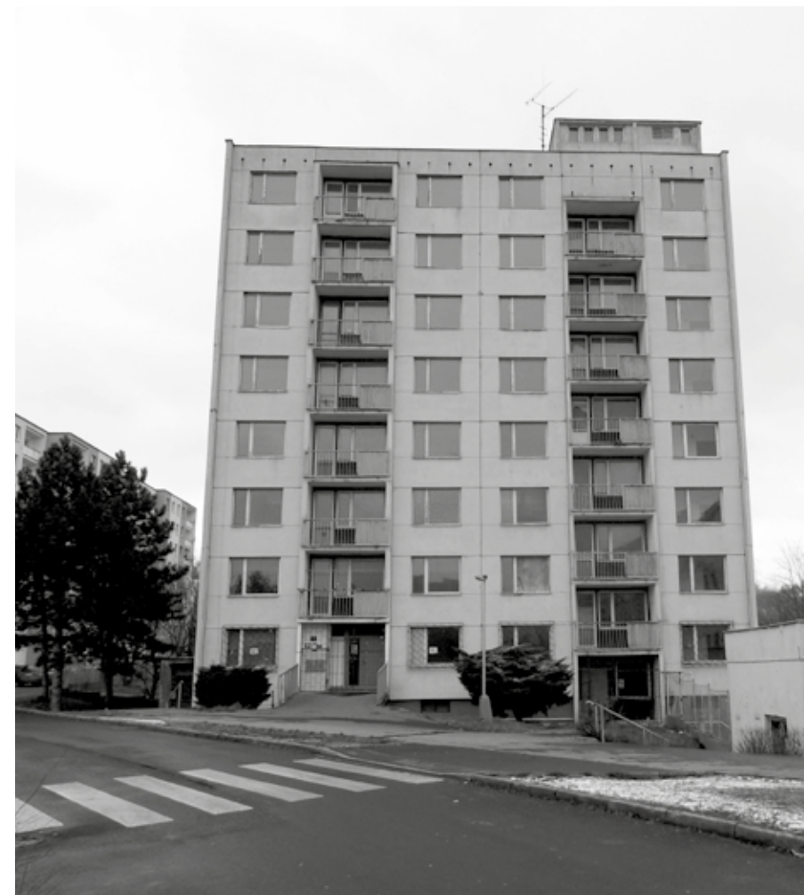
▲ Ubytovna v Ústí nad Labem
